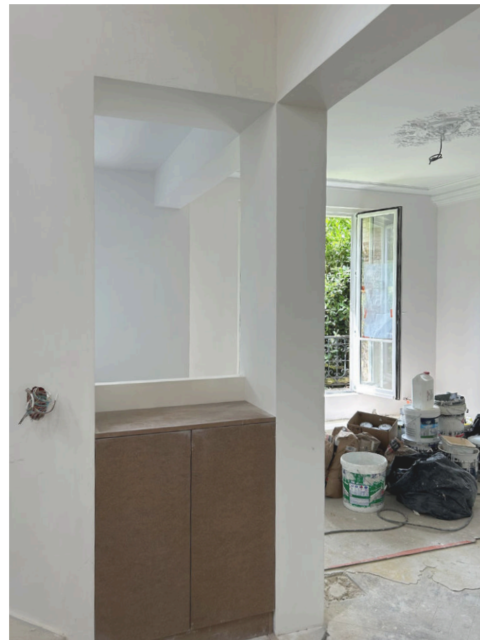
Ouverture pour la future verrière en bois
