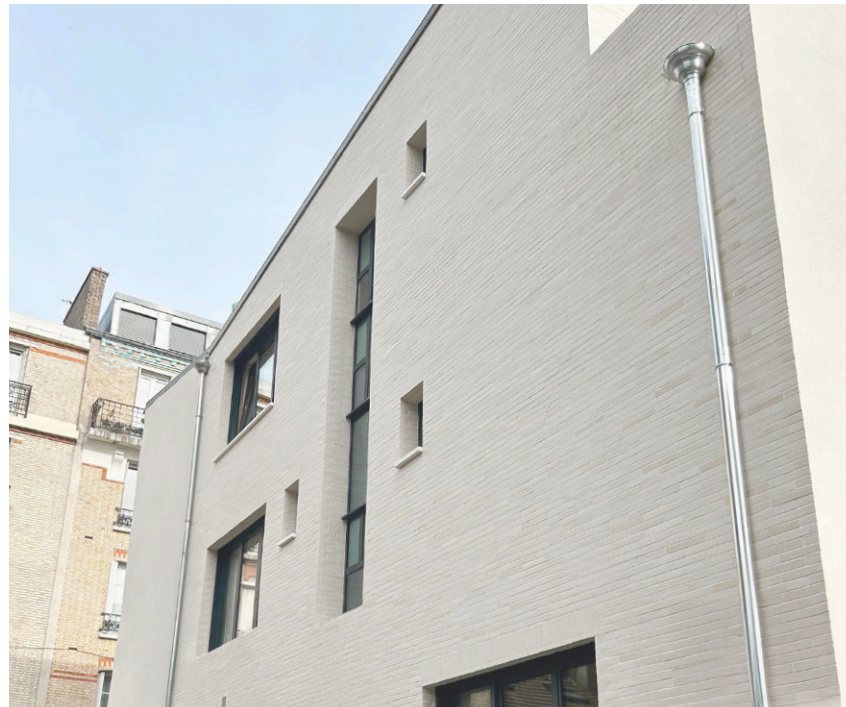
Façade après intervention
